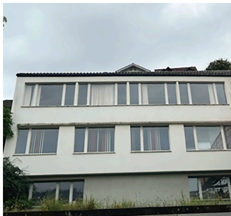
Eigenheim (Ansicht vom Haldenweg)
