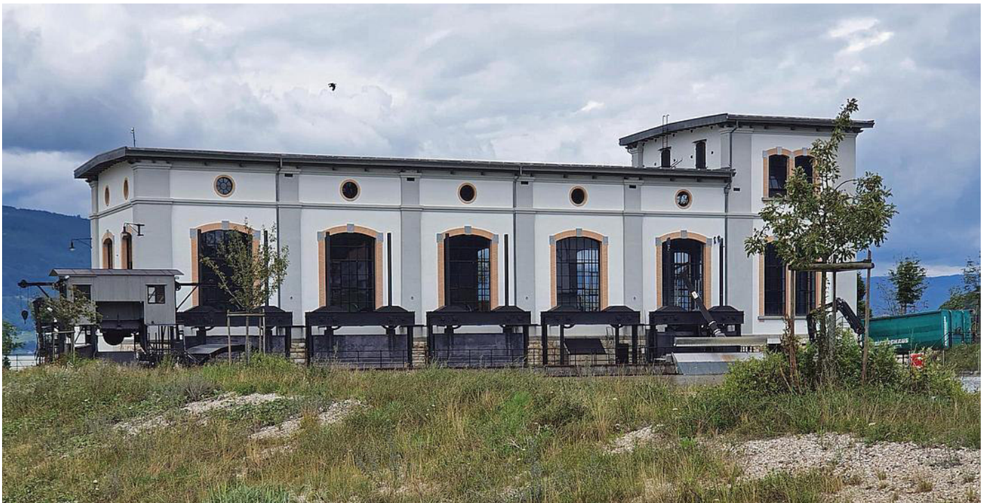
Turbinengebäude Hagneck I
