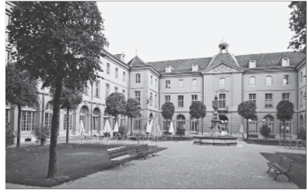
Der öffentlich zugängliche Innenhof – eine Ruhezone inmitten des tosenden Verkehrs am Berner-Bahnhof
