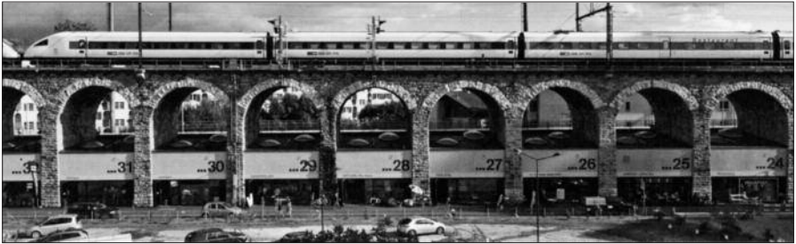
Der umgebaute Viadukt
