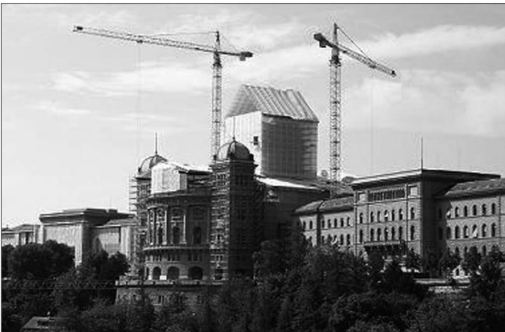
Das Parlamentsgebäude ist eine Grossbaustelle
